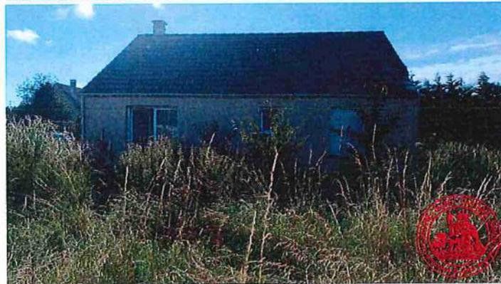
Les murs extérieurs sont recouverts d'un crépi beige. La toiture est recouverte de tuiles en terres cuites. De la mousse y est présente. Une partie de la toiture est découverte à l'arrière à proximité du pignon sud. Les gouttières et descentes sont en PVC. L'ensemble n'est pas entretenu, voire, endommagé par la chute de certaines tuiles.
